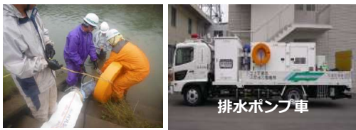
出典：浜松河川国道事務所
