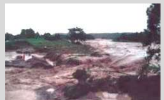
太田川破堤状況（袋井市延久付近） 出典：第2回中東遠地域豪雨災害減災協議会（H30.2.9）資料
