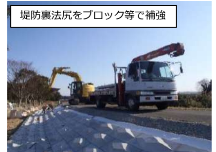
出典：浜松河川国道事務所
