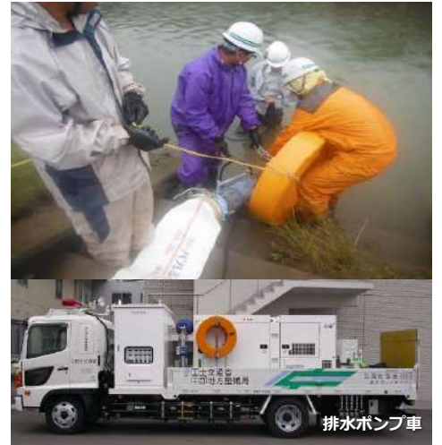
出典：浜松河川国道事務所
