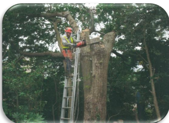
支障木の伐採作業
