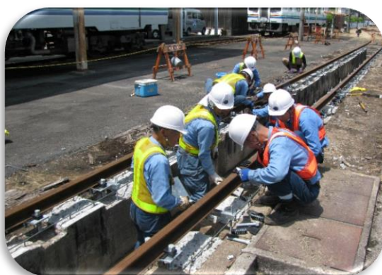
車両基地修繕
